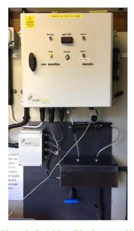
Photo de l'unité installée dans une dépendance. L'unité contrôle dispose d'une vanne d'écluse qui détourne le débit du réservoir en cas de contamination.
