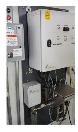
Photo montrant le MS1200 installé dans la station de pompage. L'unité est connectée à un système SCADA (Ethernet) utilisant le protocole Profibus (TCP / IP), qui enregistre les données et, en cas d'accident, active les alarmes qui arrêtent les pompes d'aspiration.
