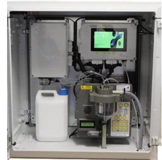
Photo montrant le MS3500, moniteur d'ammoniac pour les eaux usées brutes.
